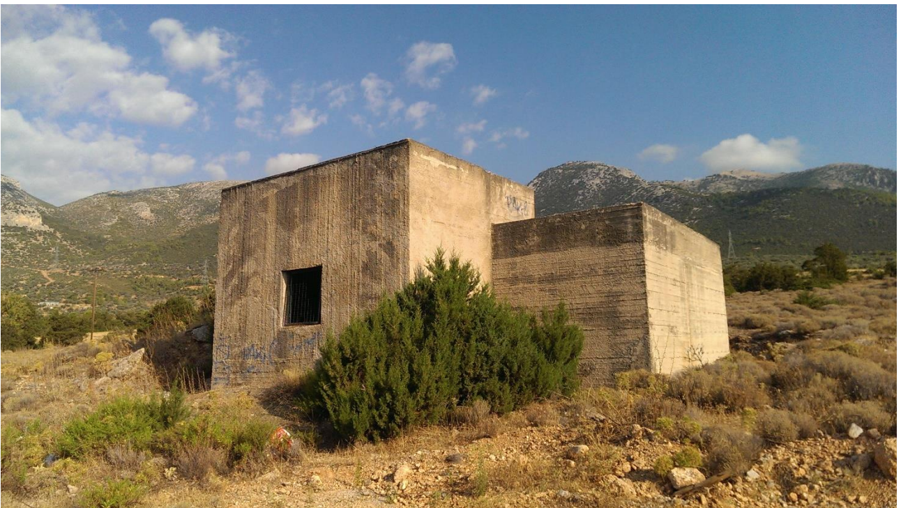
Εικόνα 30 Υφιστάμενη Δεξαμενή – Γυμνό
