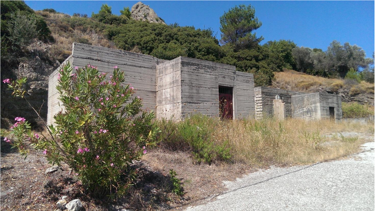
Εικόνα 43 Υφιστάμενη Δεξαμενή – Οξύλιθο
