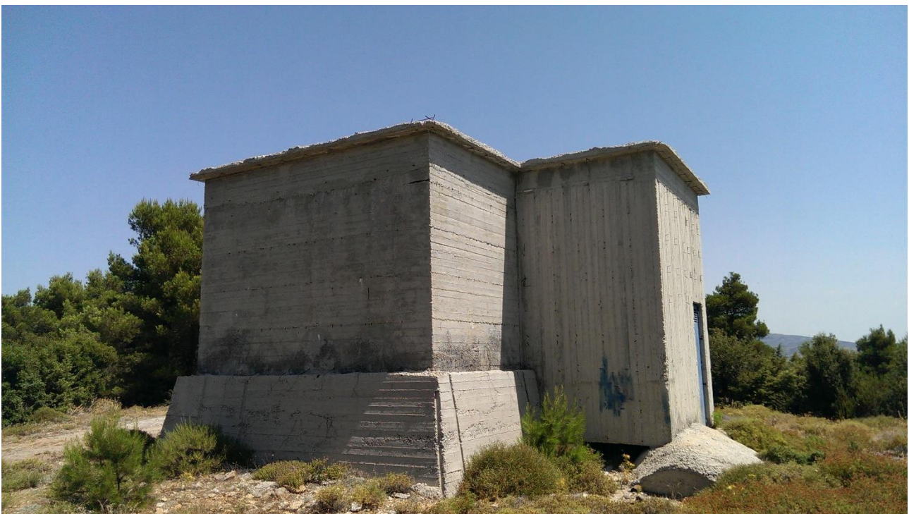
Εικόνα 26 Υφιστάμενη Δεξαμενή – Άνω Σέτα
