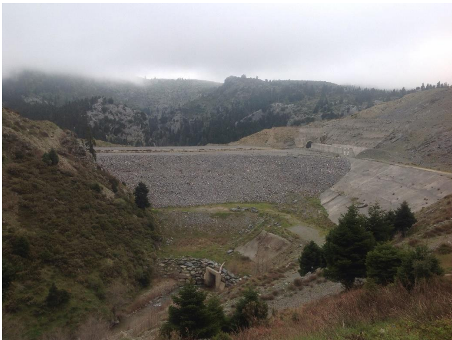
Εικόνα 11 Πανοραμική άποψη φράγματος και οχετού
