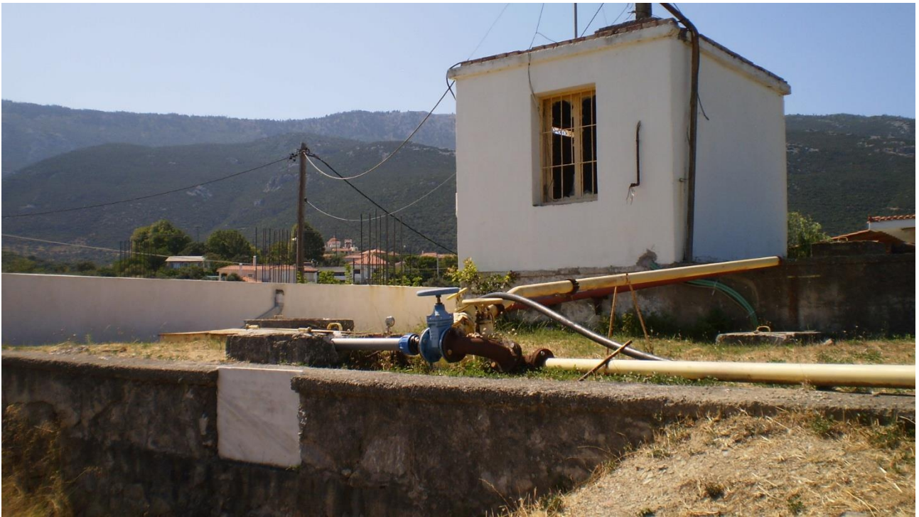
Εικόνα 39 Υφιστάμενη Δεξαμενή – Κονίστρες
