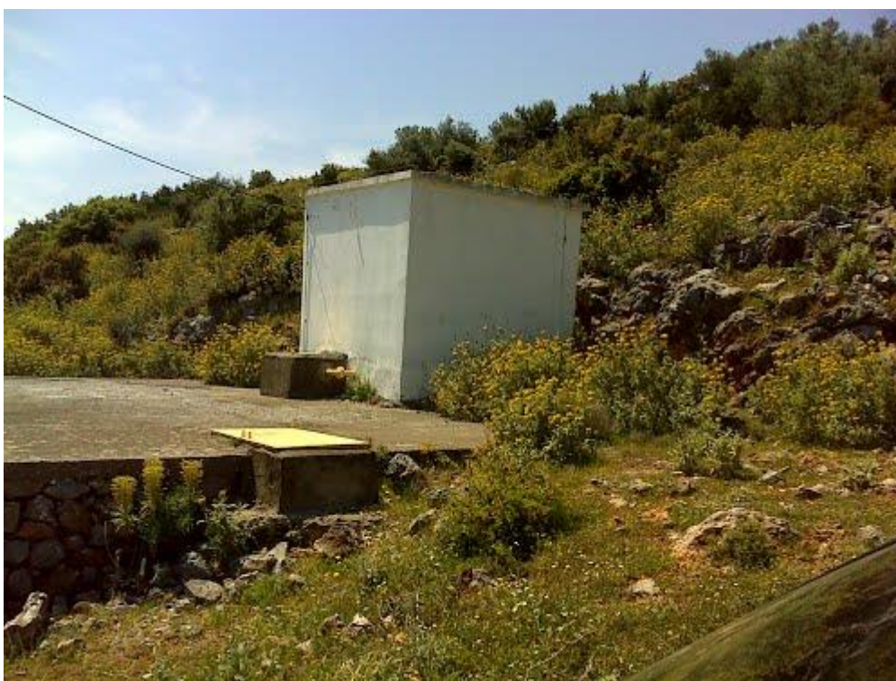
Εικόνα 32 Υφιστάμενη Δεξαμενή – Επισκοπή
