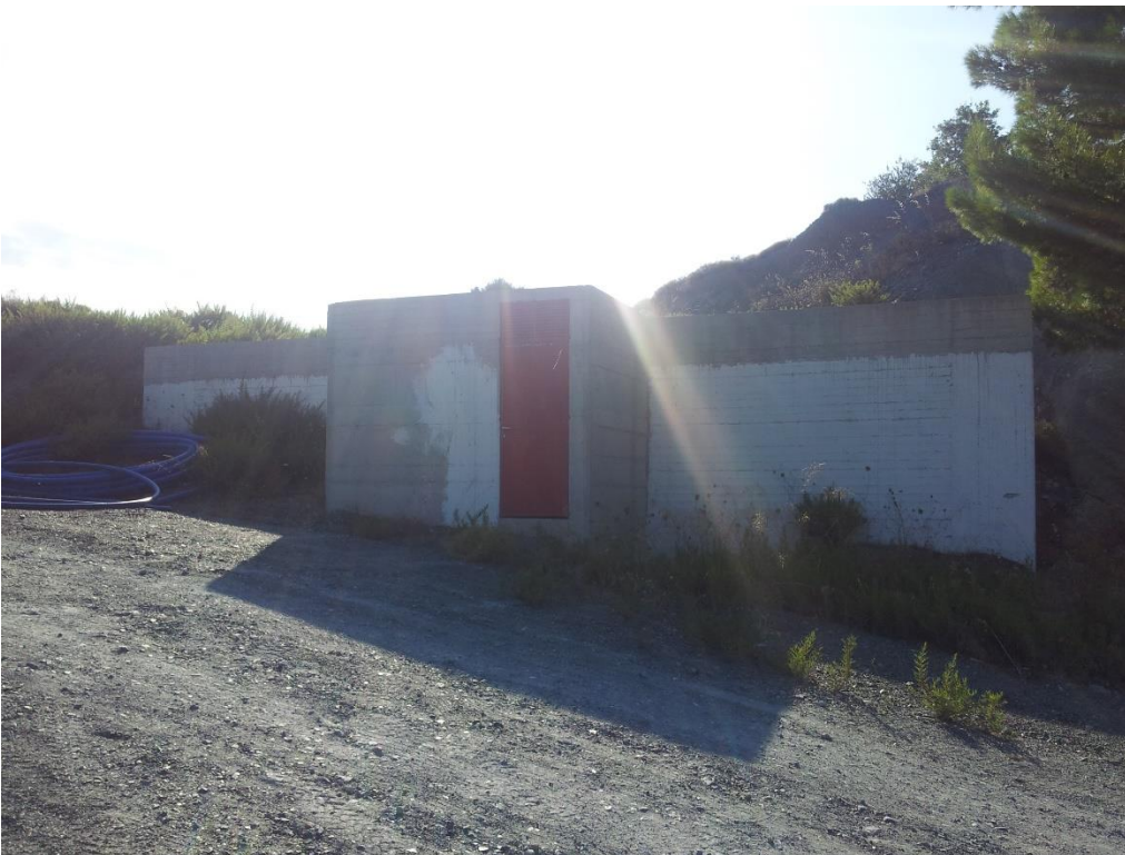
Εικόνα 34 Υφιστάμενη Δεξαμενή – Καλημεριανά
