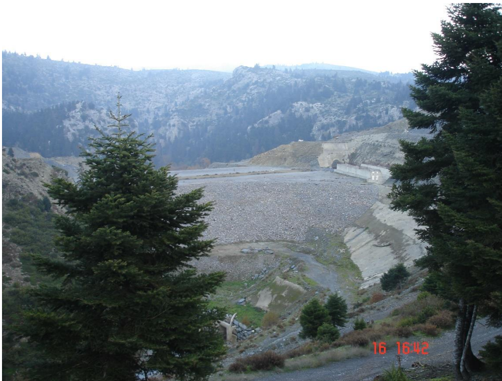
Εικόνα 15 Πανοραμική άποψη φράγματος, σήραγγας και οχετού 1.2 ΕΓΚΑΤΑΣΤΑΣΗ ΕΠΕΞΕΡΓΑΣΙΑΣ ΝΕΡΟΥ
