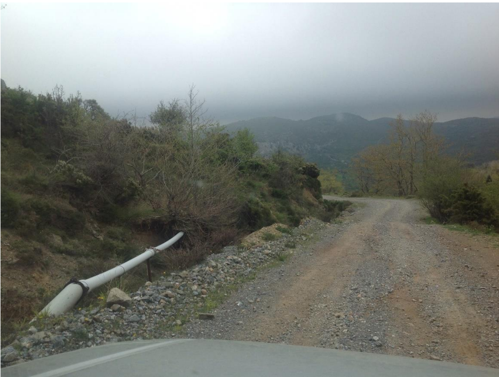
Εικόνα 18. Άποψη χωματοδρόμου και αγωγού
