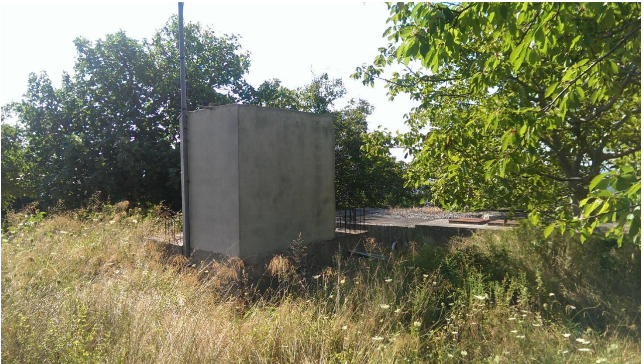
Εικόνα 27 Υφιστάμενη Δεξαμενή – Βίταλα
