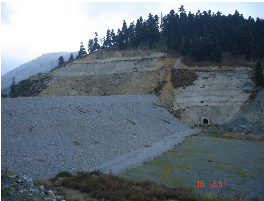
Εικόνα 12 Πανοραμική άποψη φράγματος και σήραγγας
