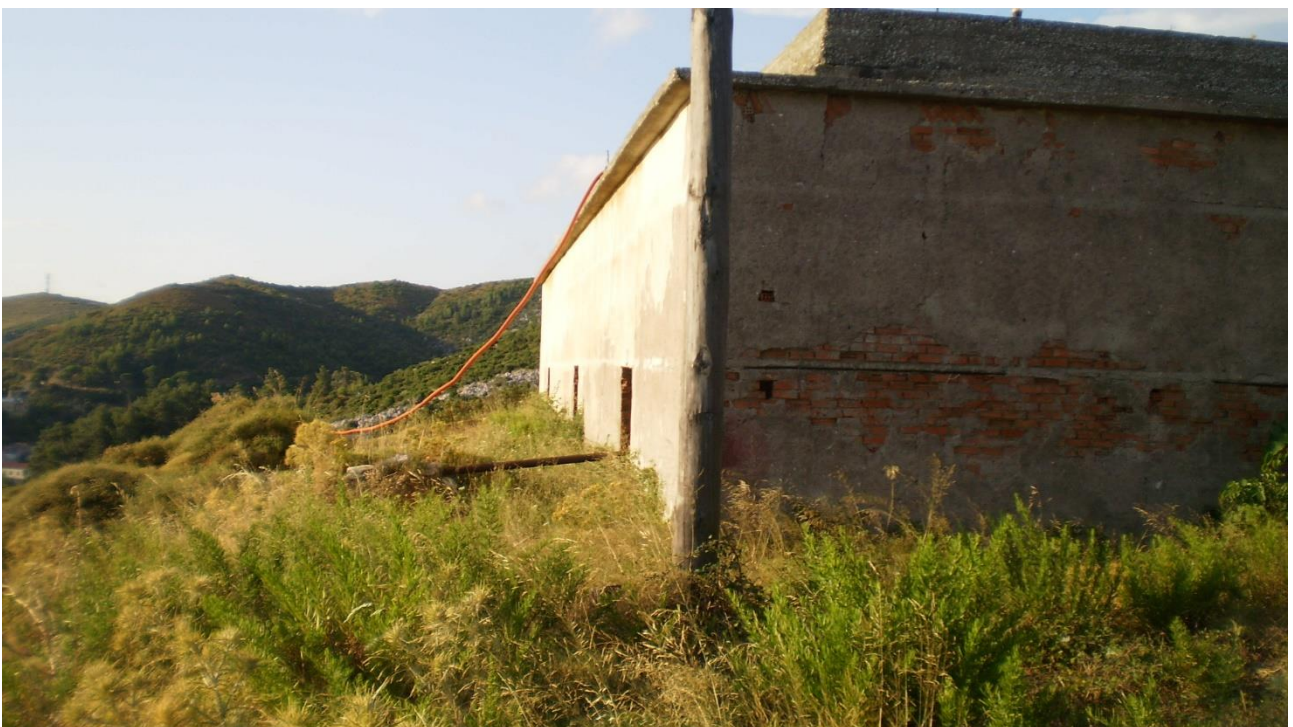
Εικόνα 40 Υφιστάμενη Δεξαμενή – Κύμη
