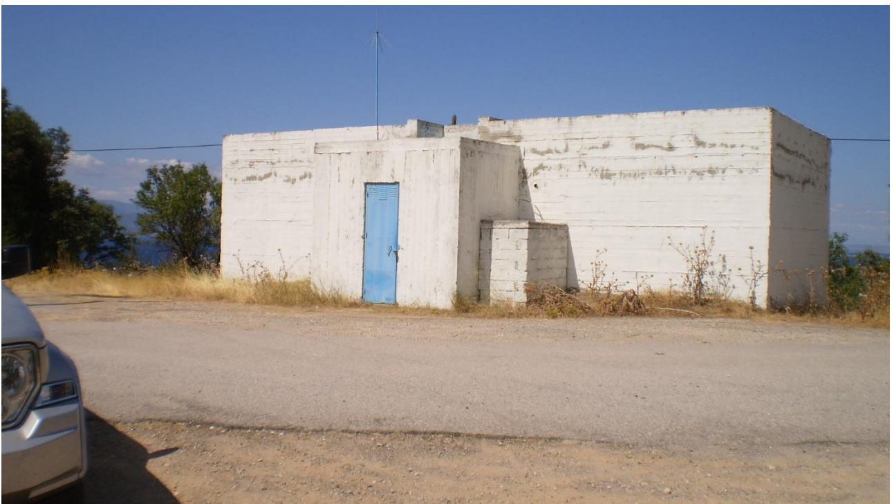
Εικόνα 24 Υφιστάμενη Δεξαμενή – Άνω Βαθειά
