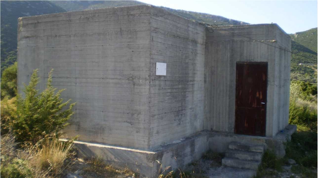
Εικόνα 33 Υφιστάμενη Δεξαμενή – Κάδιο
