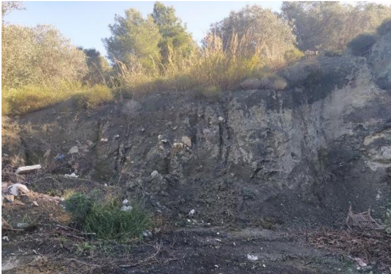
Φωτογραφία 9 Περιοχή εκσκαφής
