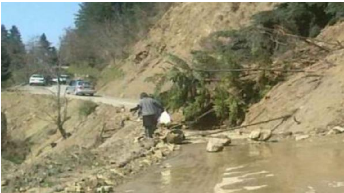
Εικόνα 235: Κατολίσθηση σε ορεινό δρόμο στην Ευρυτανία (Δεκέμβριος 2017)
